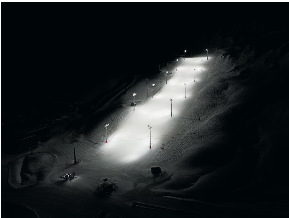
Chaque mât est équipé de 17 projecteurs Altis à distribution lumineuse symétrique et asymétrique de 5 700 K et 3 000 K.
