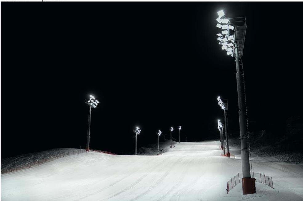
A la hora de colocar las luminarias, se determinó el equilibrio óptimo entre el número de mástiles y la altura de los puntos de luz para garantizar que la iluminación cumpliera las normas.
